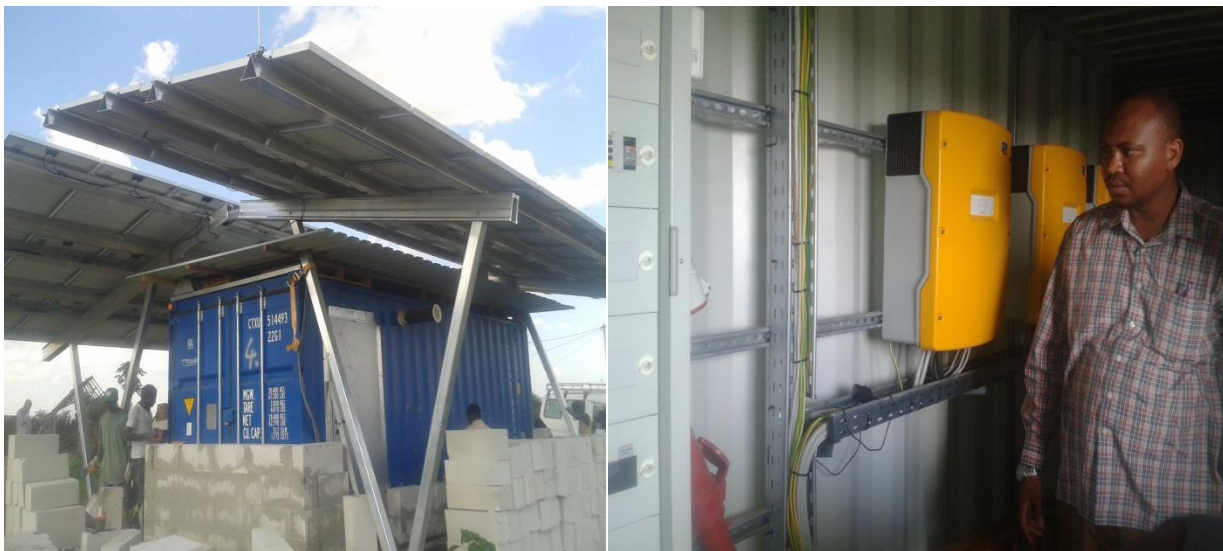
Ujenzi wa mitambo ya kuzalisha umeme jua katika kijiji cha Ngutoto-Kongwa
