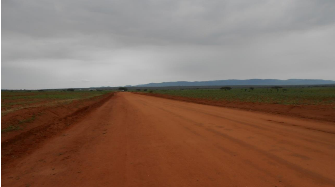
Sehemu ya barabara ya Suguta-Kibaigwa (km 15) ambayo inafanyiwa matengenezo
