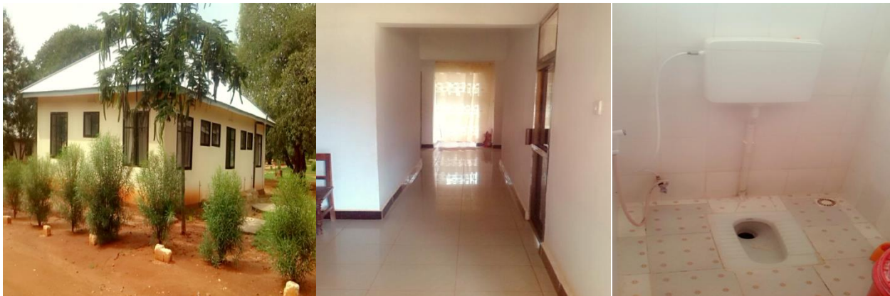
Jengo la wodi 'Grade A' lililopo katika Hospitali ya Wilaya linavyoonekanakwa ndani na nje
